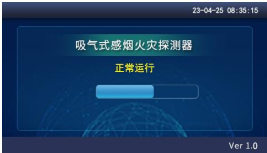
正常运行界面（7-2-1）
